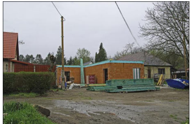
A tárgyi ingatlan nézete a Nagyduna tér felől a megkezdett építkezéssel
