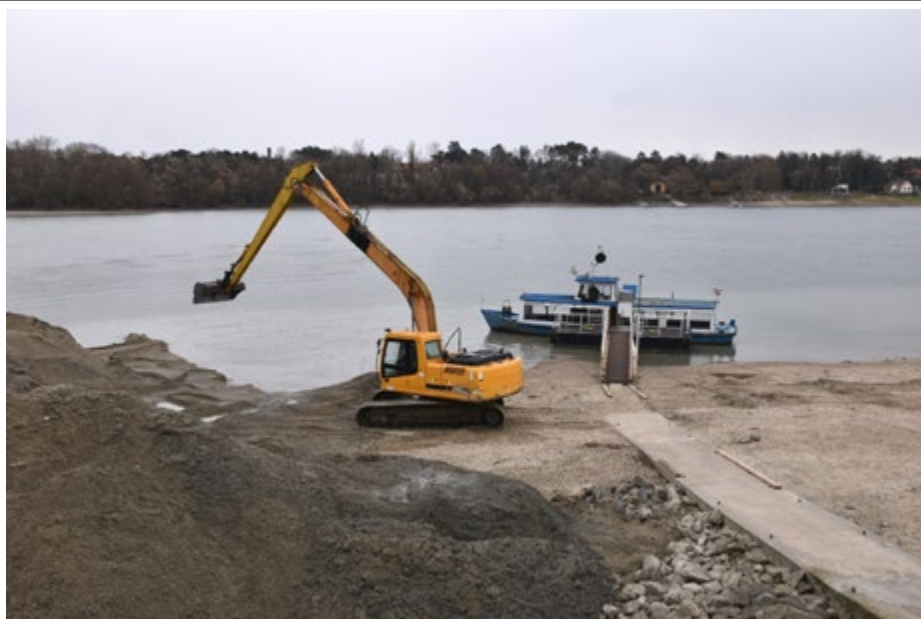
Megkezdődött az alsógödi kishajó manőverterének kotrása
