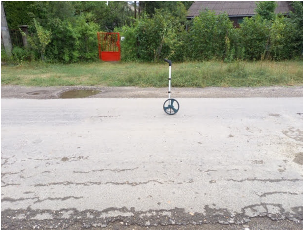
4./ Horánygyöngye utca repedezett aszfalt burkolata kijárt padkákkal
