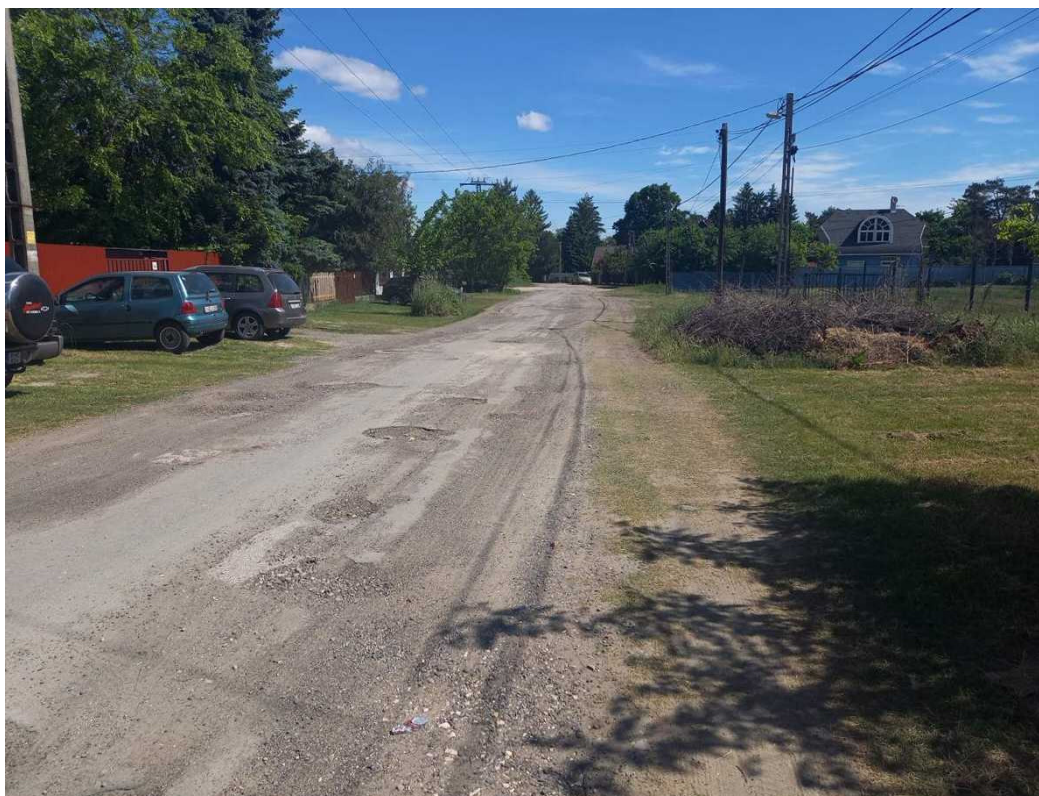
3./ Horánygyöngye utca jellemző keresztmetszete a kátyúsodott felülettel
